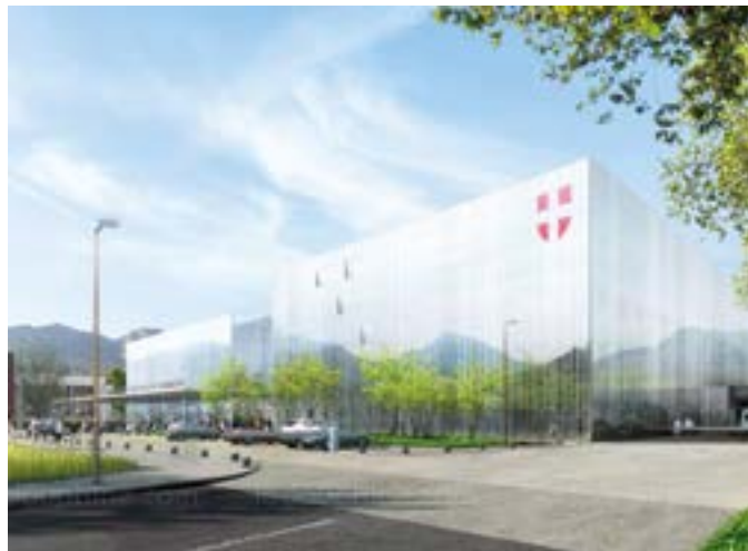
Ospedale di Chambéry - Chambéry (Francia)
